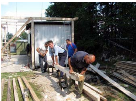
Pripreme za izgradnju drvene nadstrešnice iznad novog kontejnera
