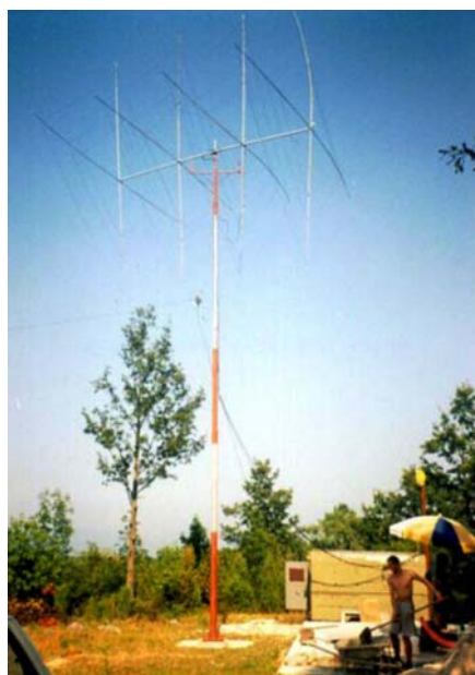
Dobrovoljni rad članova YU1AAX, na kontest lokaciji, u nalivanju betonske ploče za novi kontejner
