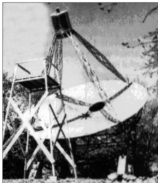
Slika 3. Prva antena Grote Rebera: 11-m tanjir, sagrađen 1937. Foto: NRAO [11]
