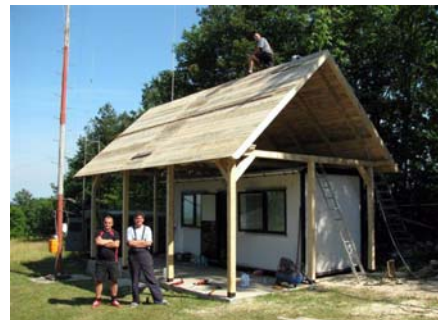
Radovi su završeni i krov je postavljen
